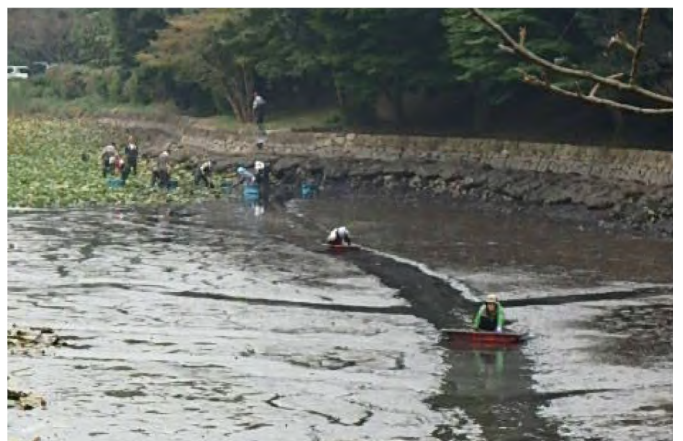
▲ 排水用の「滞筋」を付けているのは研修参加者（三ツ池公園）
