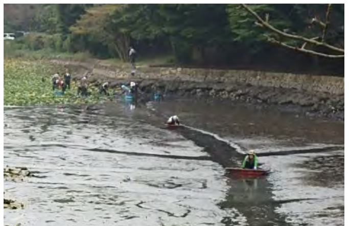
▲ 排水用の「滞筋」を付けているのは研修参加者（三ツ池公園）
